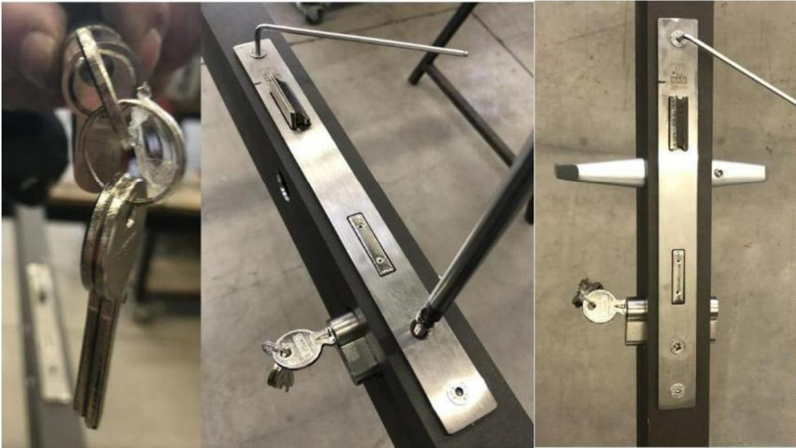
Une fois que la serrure du cadre tubulaire a été insérée dans le profilé du cadre à gauche et fixée à l'aide des vis en haut et en bas, le cylindre de fermeture (attention à la position de la clé) peut être monté dans le profilé du cadre à gauche. Lors de la dernière étape du montage de l'unité de fermeture, il faut encore installer la garniture de poignée. Le montage de l'unité de fermeture est maintenant terminé. On continue avec le prémontage du cadre (profilé à gauche et en bas).
